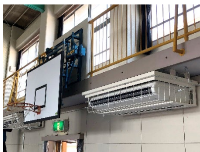
岐阜県岐阜市 三輪南小学校
