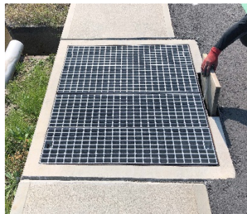
堰操作の様子
