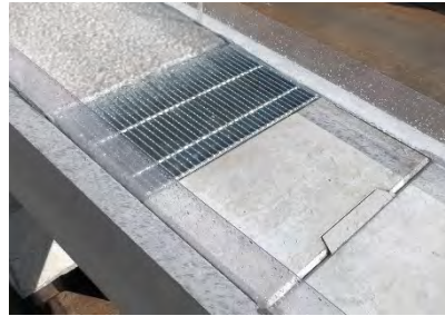
流水実験の様子 (バキュームグレーチング)
