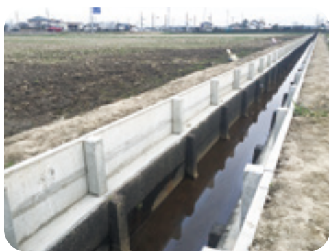
杭打ち+コンクリート板
