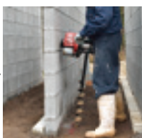
杭基礎穴掘り
