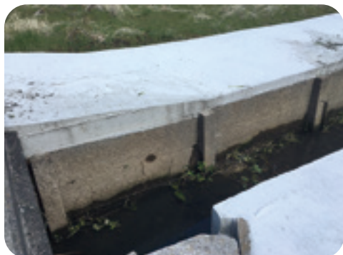
型枠+コンクリート打設
