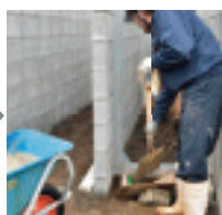
コンクリート流し込み
