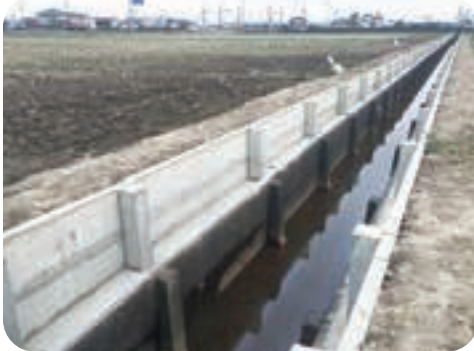
杭打ち+コンクリート板
