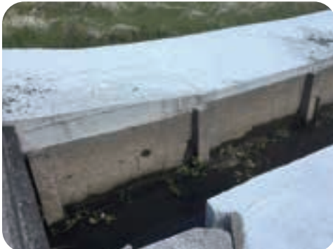
型枠+コンクリート打設
