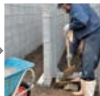
コンクリート流し込み
