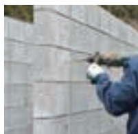
ボルト穴あけ
