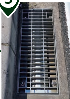
グレーチングを設置
