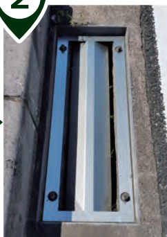
ボーソー板 ばん を設置
