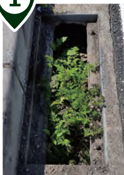
グレーチングを外す
