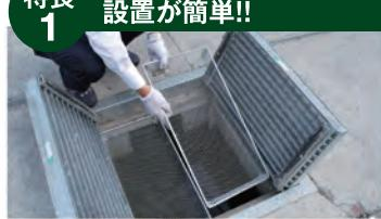
クリーンキーパーは集水枠の蓋を外して乗せるだけで簡単に設置できます。
