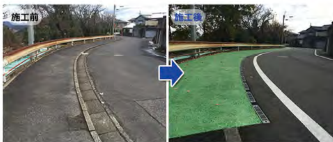
【岐阜県各務原市】歩車道フラット化 全長70m 工期5日
