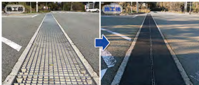
【熊本県小国町】スリップ対策 全長20m 工期1日
