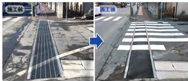
【岩手県釜石市】スリップ対策 全長8m 工期4時間
