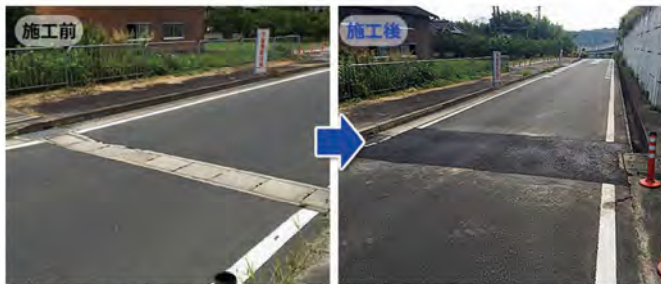
【和歌山県橋本市】騒音対策 全長4.5m 工期5時間
