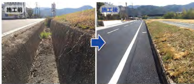
【兵庫県穴栗市】道路拡幅 全長200m 工期1日*
