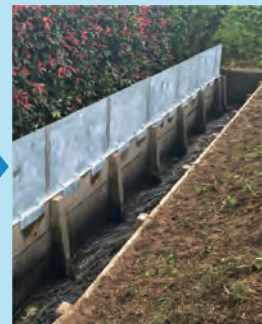
埋戻し・施工完了
