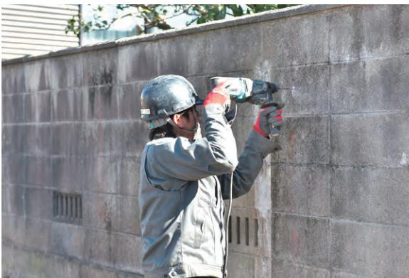
●ボルト取り付け用の貫通穴を空ける
