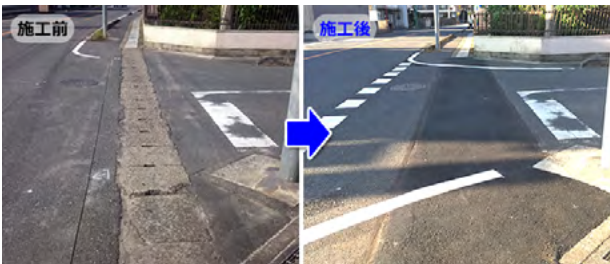
埼玉県 [工期] 2日/全長28m 老朽化対策
