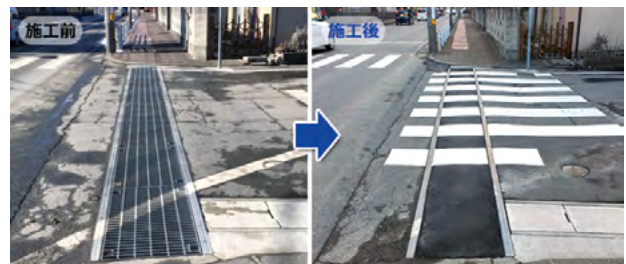
岩手県 [工期] 半日/全長8m スリップ対策
