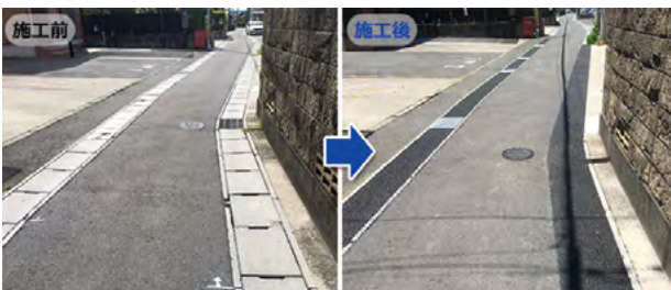
愛知県 [工期] 4日/全長93m 騒音対策
