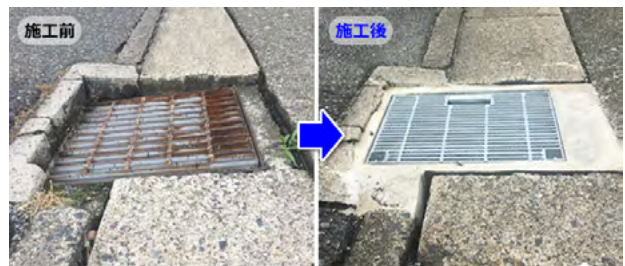
愛知県 [工期] 半日/2基 集水樹の改修
