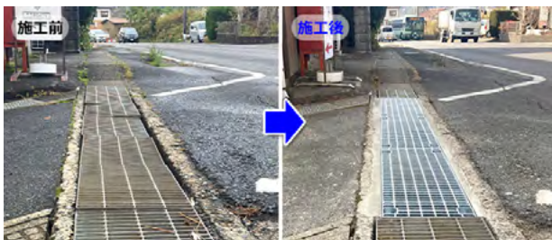
岐阜県 [工期] 半日/全長4.2m 横断側溝の改修
