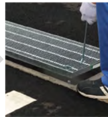
4 グレーチング取付
