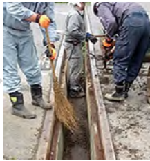
2 蓋撤去・清掃
