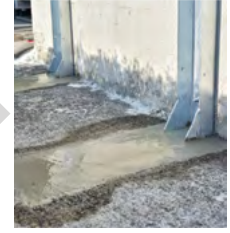
5 コンクリート流し込み
