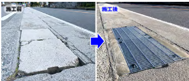
長野県 [工期] 2日/6ヶ所 可変側溝の改修
