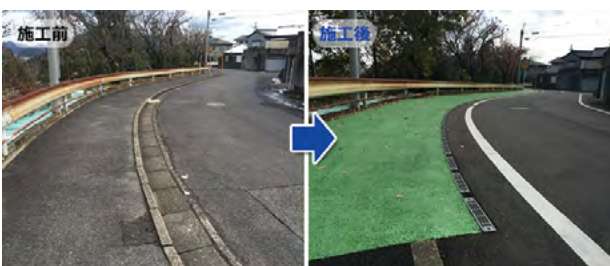
岐阜県 [工期] 5日/全長70m 歩車道フラット化
