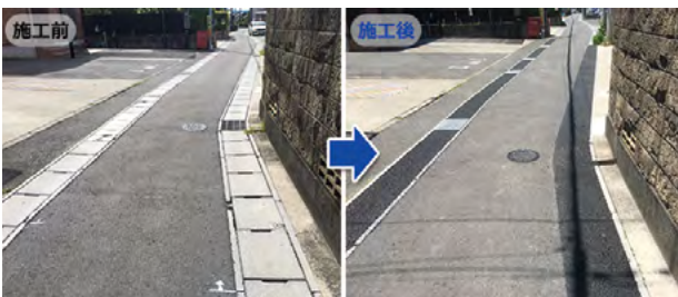
愛知県 [工期] 4日/全長93m 騒音対策
