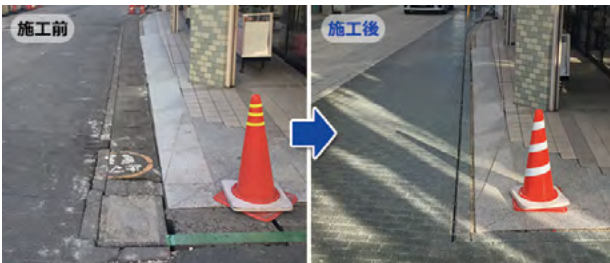
愛知県 [工期] 14日/全長130m 景観改修工事
