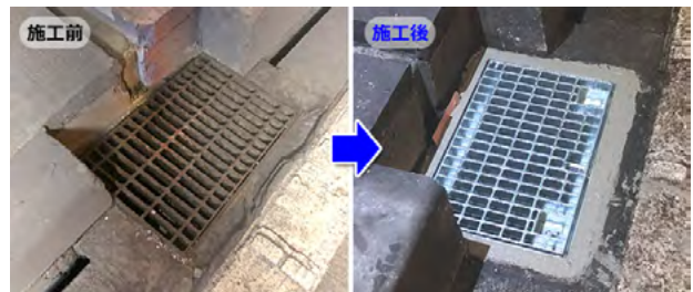
山梨県 [工期] 3日/30基 円形水路管理口の改修
