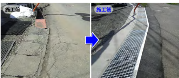
長野県 [工期] 半日/全長10m 新設側溝の破損対策
