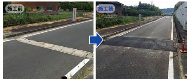
和歌山県 [工期] 半日/全長4.5m 破損対策
