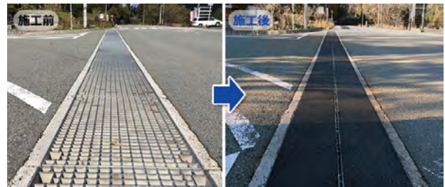
熊本県 [工期] 1日/全長20m スリップ対策
