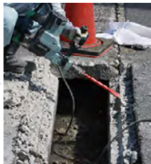
2 立ち上がり部切断
