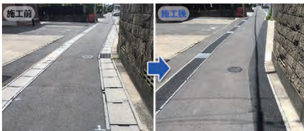
愛知県 [工期] 4日/全長93m 騒音対策
