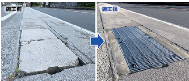
長野県 [工期] 2日/6ヶ所 可変側溝の改修
