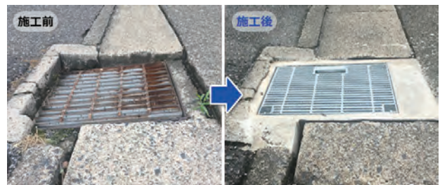
愛知県 [工期] 半日/2基 集水樹の改修
