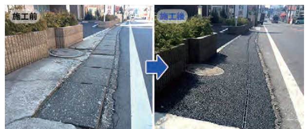
千葉県 [工期] 1日/全長18m 騒音対策
