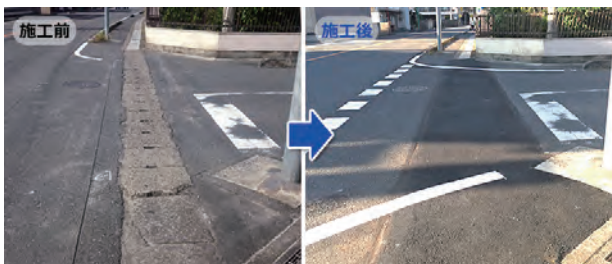
埼玉県 [工期] 2日/全長28m 老朽化対策
