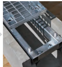
4 グレーチング取付
