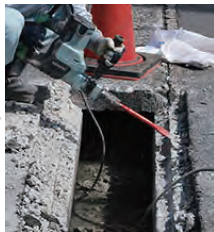
2 立ち上がり部切断
