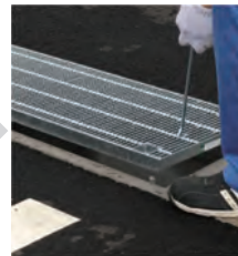
4 グレーチング取付
