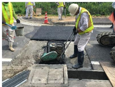
側溝から両側700mm程度既設アスファルトをはつり、水路上部と舗装を均一にすることで車両通行時の側溝への負担を緩和できます。
