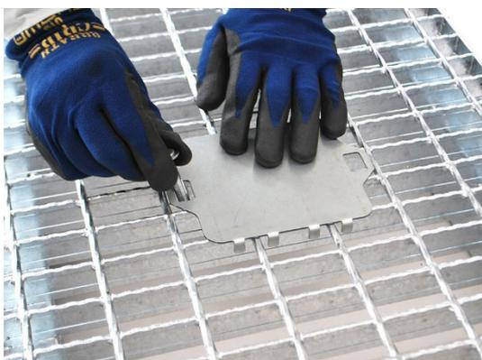
1. 施工位置に後付けデコレーションプレートを置きワッシャー・ボルトを通します。
