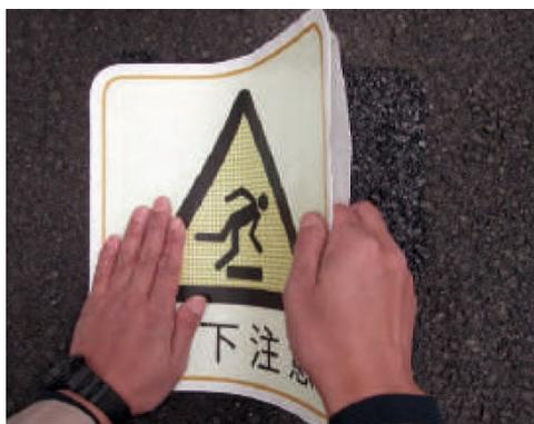
2. プライマーの硬化（夏場10分以上、冬場30分以上）を確認後、空気が残らないようにシールを貼り付けます。
