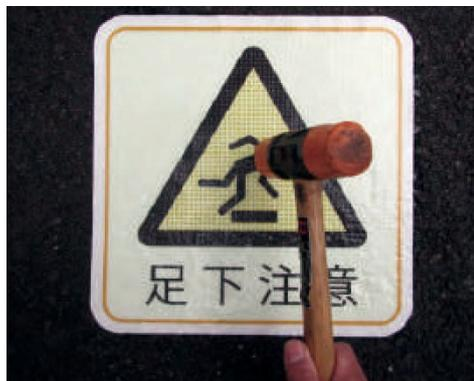
3. プラスチックハンマー等で下地の凹凸になじむように全体を叩き圧着します。
