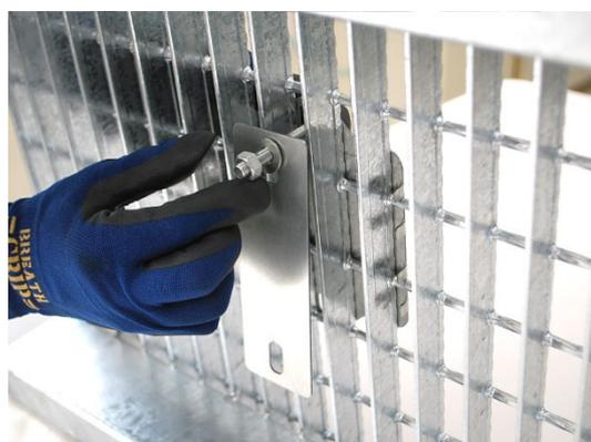
2. 裏側から固定用プレート・ワッシャー・ナットを取り付けます。
